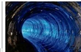
Der Abwasserkanal Emscher von innen
